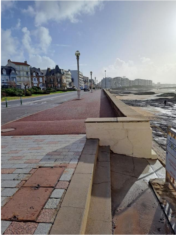
1- Photo du parapet vu du remblai
