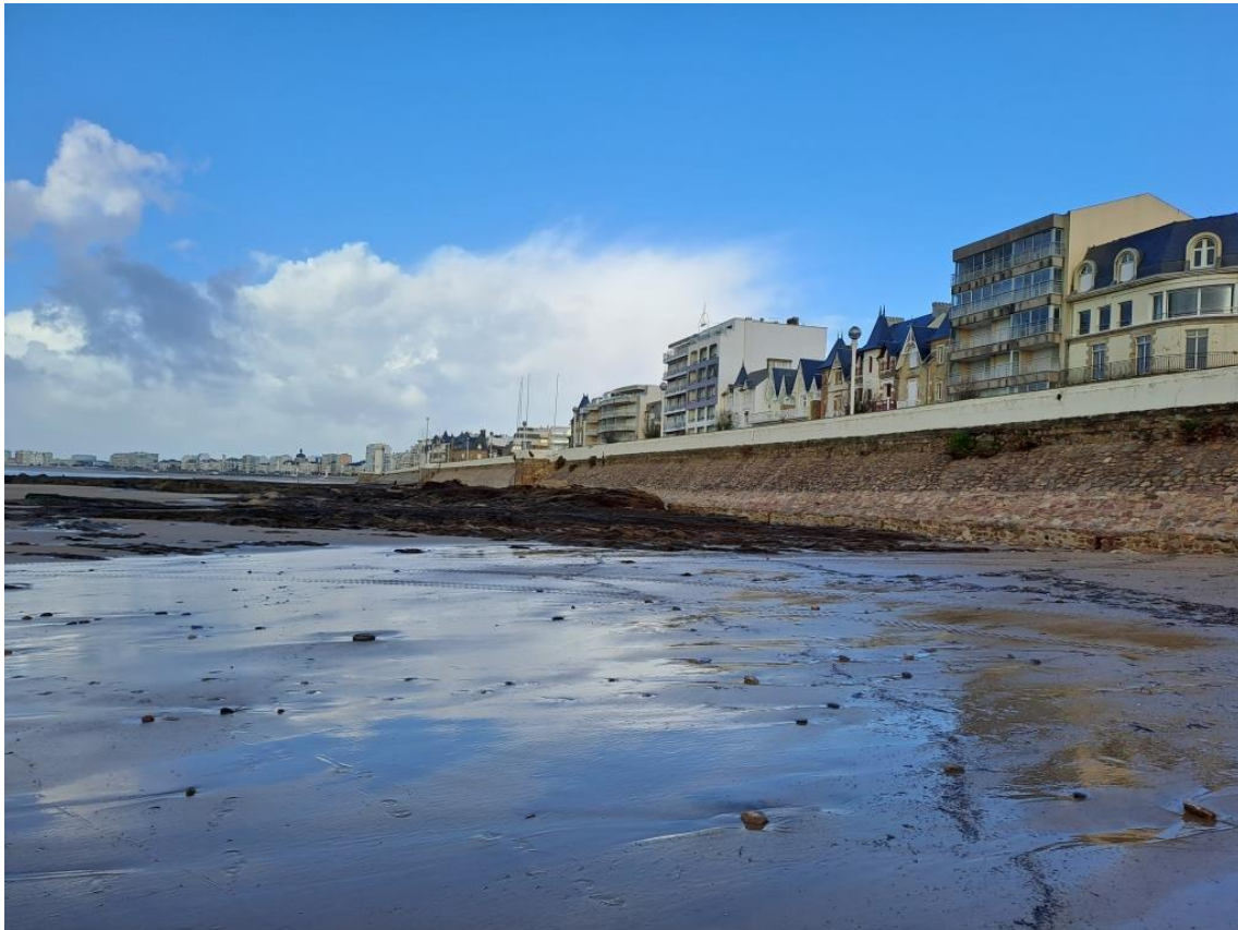
2- Photo du parapet vu de la mer
